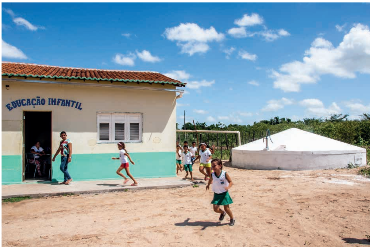
Figura 7 - Cisterna escolar em Caraúbas - RN
