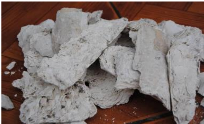
Figura 52 – Sedimentos de calcário acumulados dentro do encanamento
